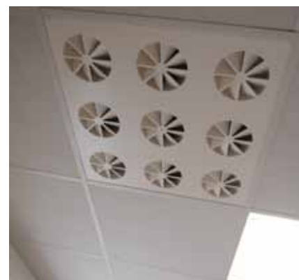
Photo 3. Caissons d'introduction d'air de compensation en salle de macroscopie
