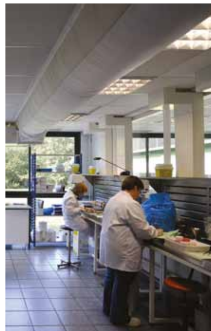
Une gaine de diffusion d'air dans le local de macroscopie
