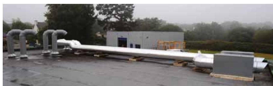
Photo 2. Les centrales de traitement d'air
