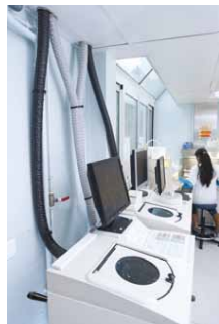
Raccordement des automates de déshydratation et d'inclusion
