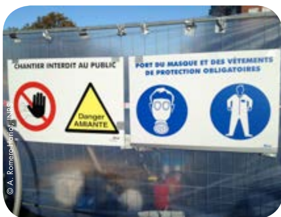
Signalétique de chantier en extérieur
