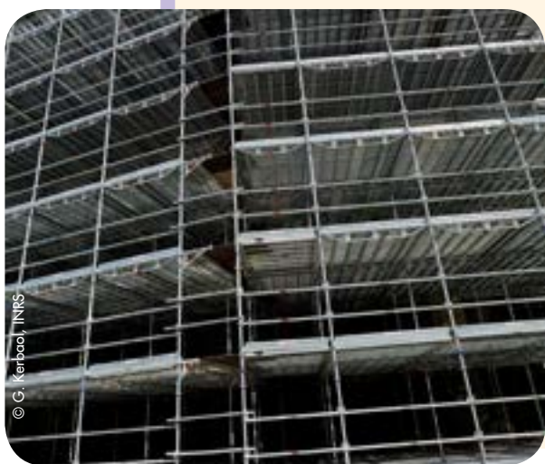
Échafaudage de façade
