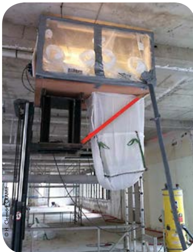
Enceinte confinée de hauteur d'étage
