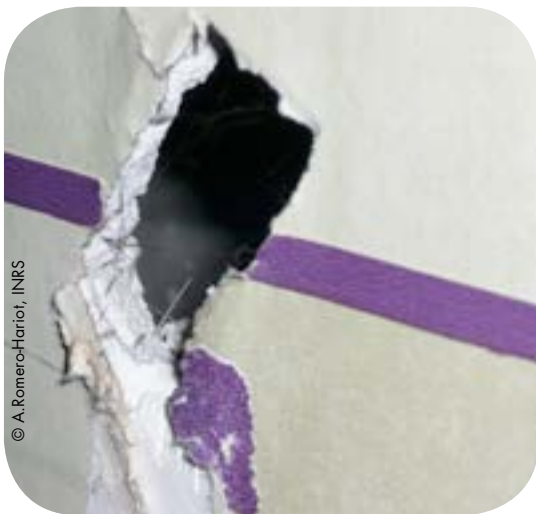
Sondage destructif lors d'un repérage avant travaux
