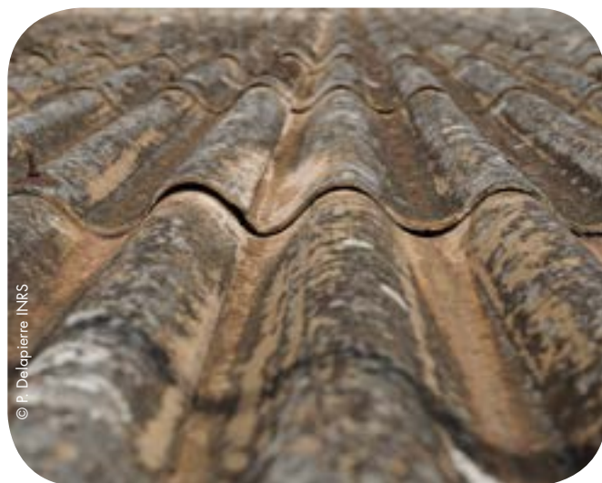
Toitures en amiante-ciment
