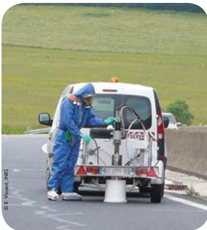
Carottage de chaussée à l'humide
