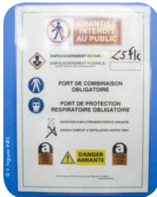
Signalétique de chantier en intérieur
