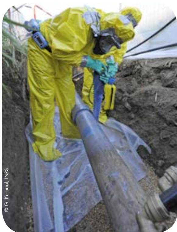
Sciage d'une canalisation à la scie égoïne
