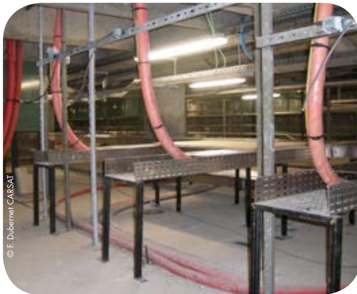
Tirage de câbles dans un environnement pollué
