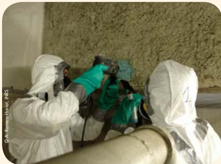
Perçage dans un flocage amianté
