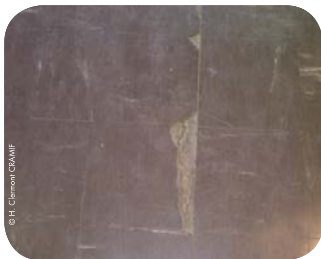
Dalles de sol en vinyle-amiante
