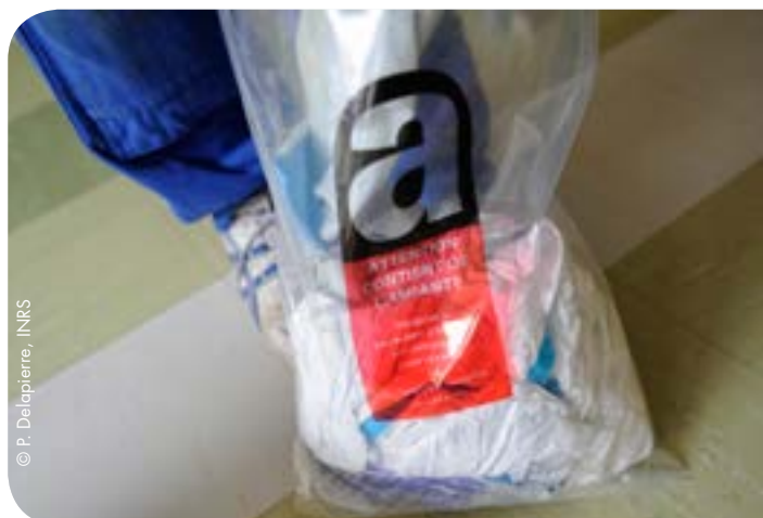
Déchets d'amiante conditionnés
