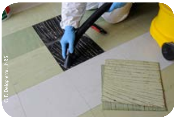
Nettoyage par aspiration avec aspirateur THE
