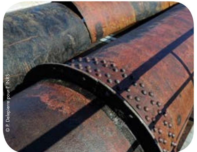
Conduite forcée revêtue de peinture bitumineuse amiantée
