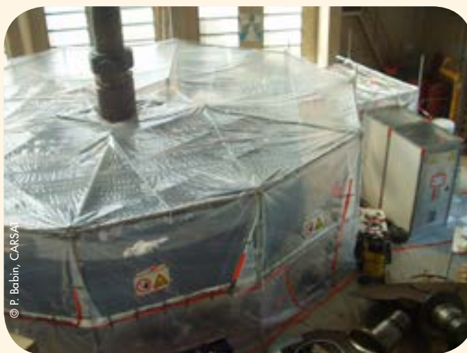
Confinement du rotor avec installation de décontamination
