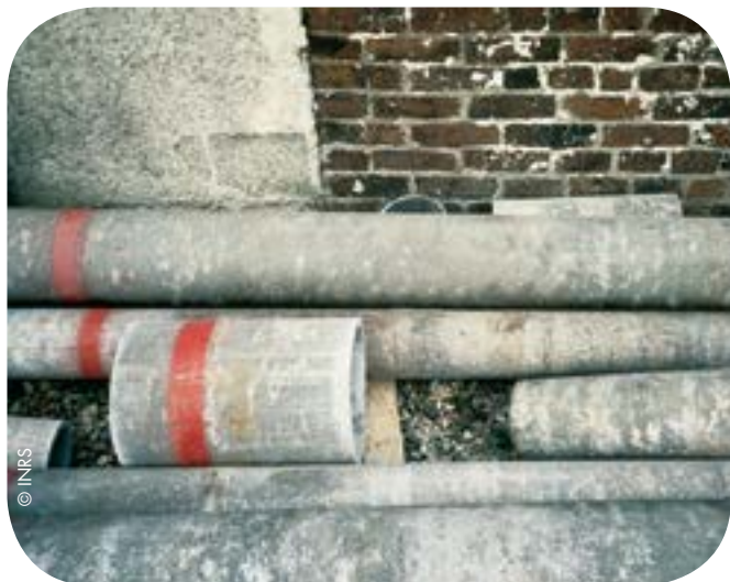
Canalisation en amiante-ciment
