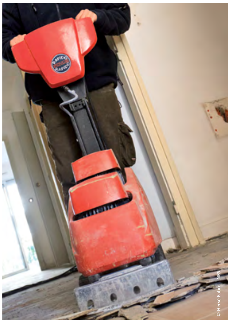
Retrait mécanisé de carrelage
