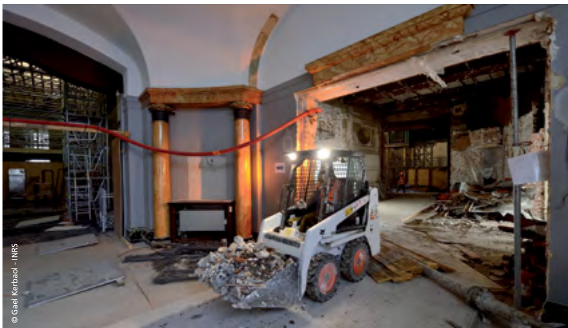
Manutention mécanisée de gravats
