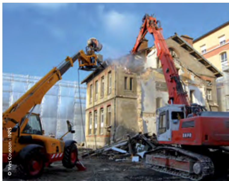
Abattage d'un bâtiment avec brumisation
