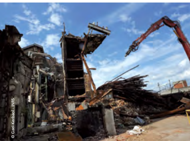
Démolition de structure métallique à la pince
