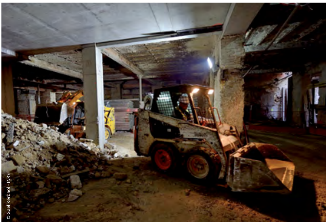
Coltinage mécanisé réalisé avec une mini-chargeuse
