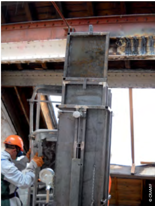
Dispositif d'aspiration des fumées de découpe par oxycoupage réglable en hauteur
