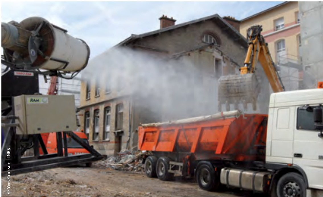
Chargement de déchets avec brumisation
