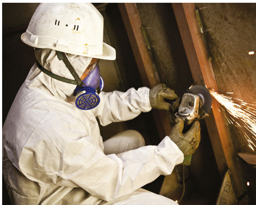
Intervention ponctuelle sur une structure métallique.
