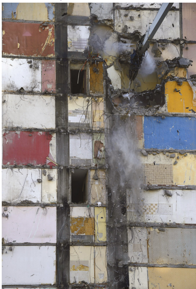
Abattage d'un bâtiment avec brumisation.
