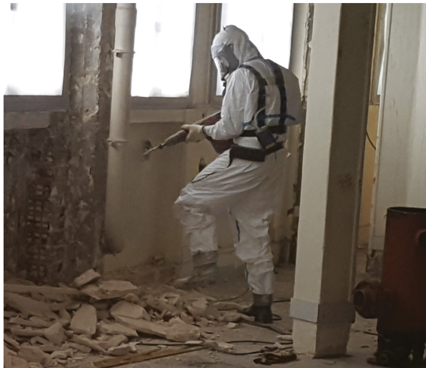
Retrait de peinture au plomb par piquage dans une zone confinée.
