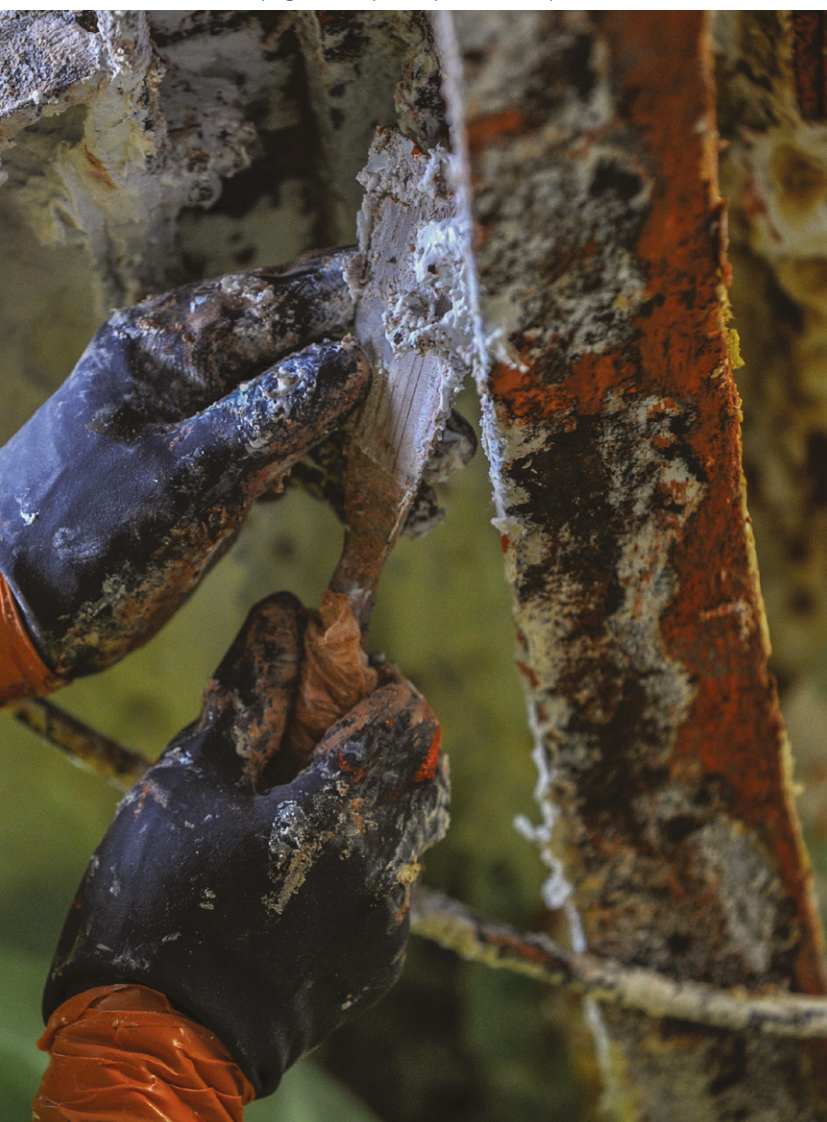
Décapage chimique de peinture au plomb.
