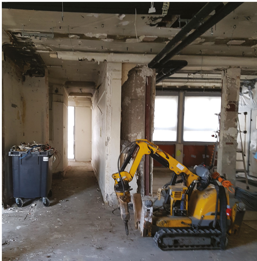
Robot de démolition dans une zone confinée.
