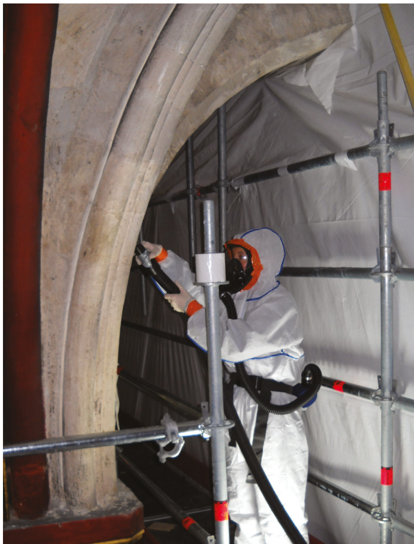
Nettoyage par aspiration de poussières contenant du plomb.
