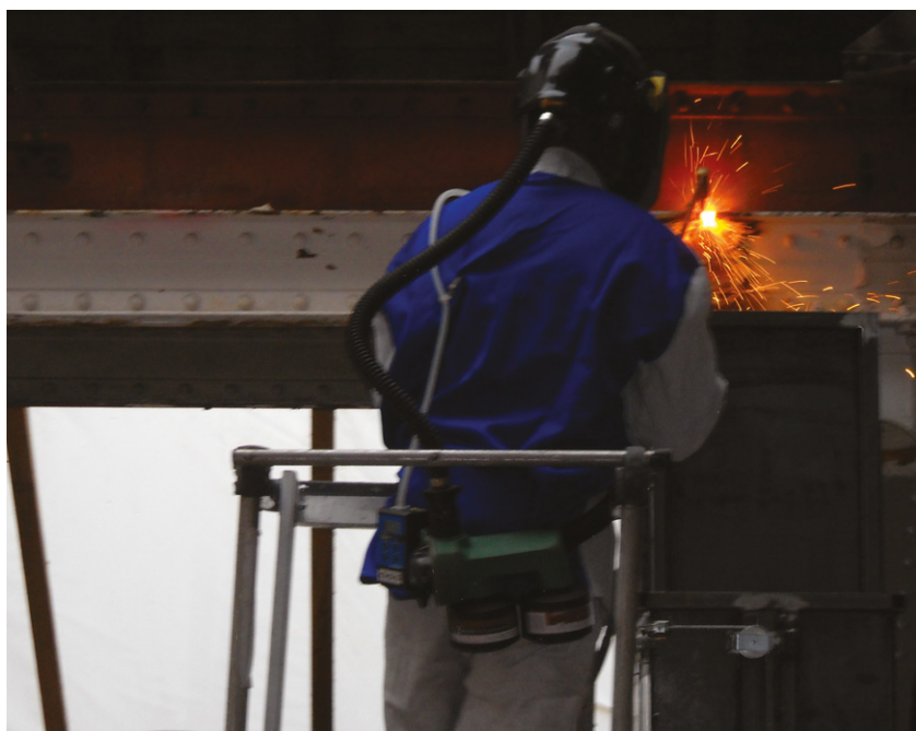
Oxycoupage d'une poutre métallique recouverte de peinture au plomb avec aspiration à la source des fumées.
