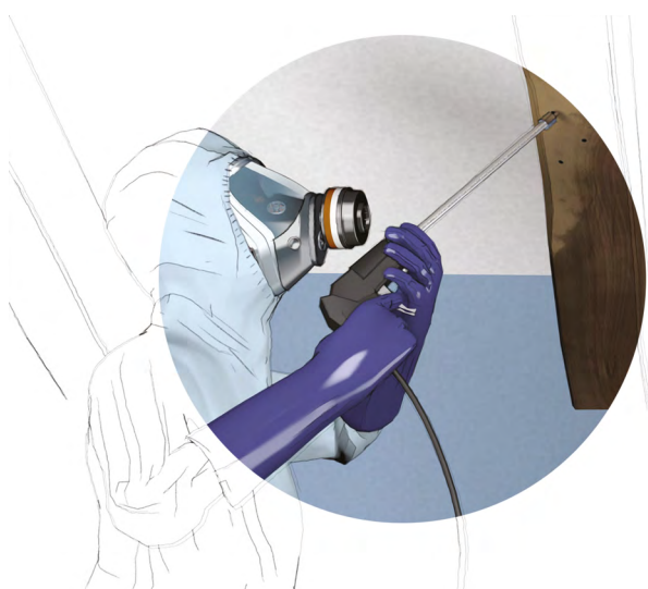
■ Figure 5. Injection du produit de traitement 2
