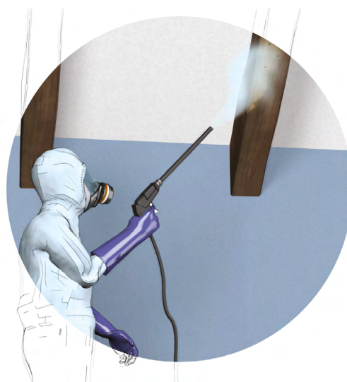
■ Figure 6. Application par pulvérisation du produit de traitement sur toutes les surfaces 2
