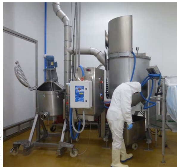
■ Caisson et cuve de mélange en position haute
