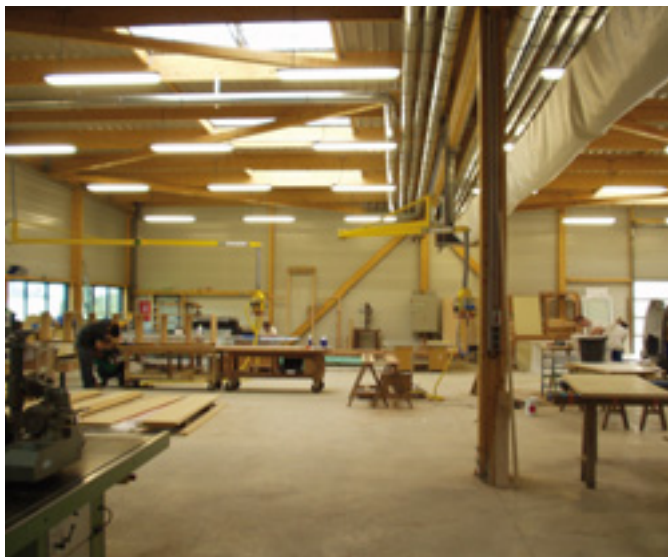
Réseau de ventilation.
