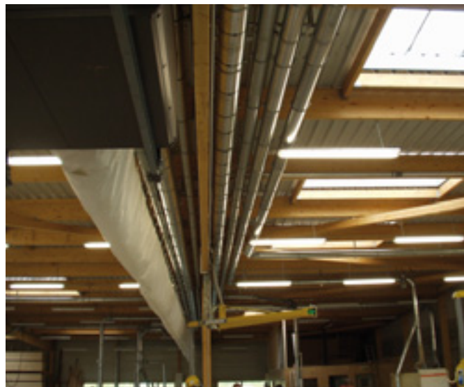
Détail du réseau de ventilation.
