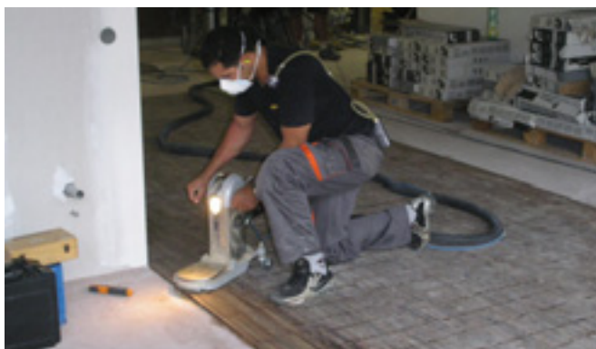
Bordeuse avec dispositif de captage des poussières.
