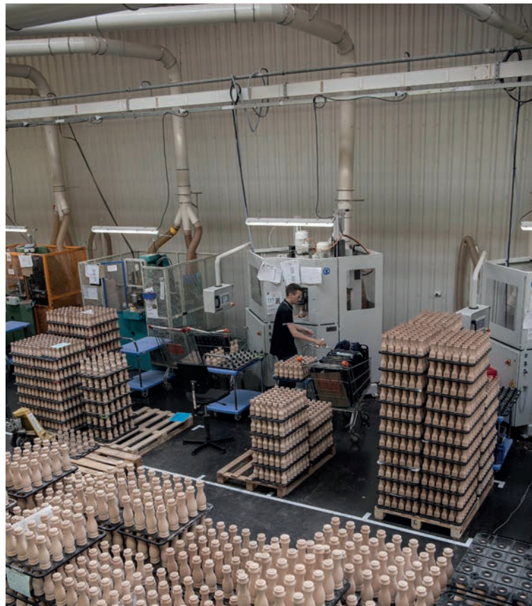
■ Atelier équipé d'un réseau d'aspiration des poussières de bois
