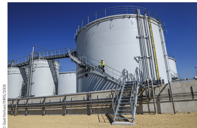
Photo 8.2 – Accès et protection collective sur un bac de stockage.
