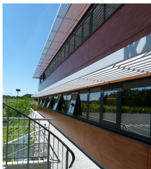
■ Photo 5.1 – Dispositif de casquette brise-soleil.
