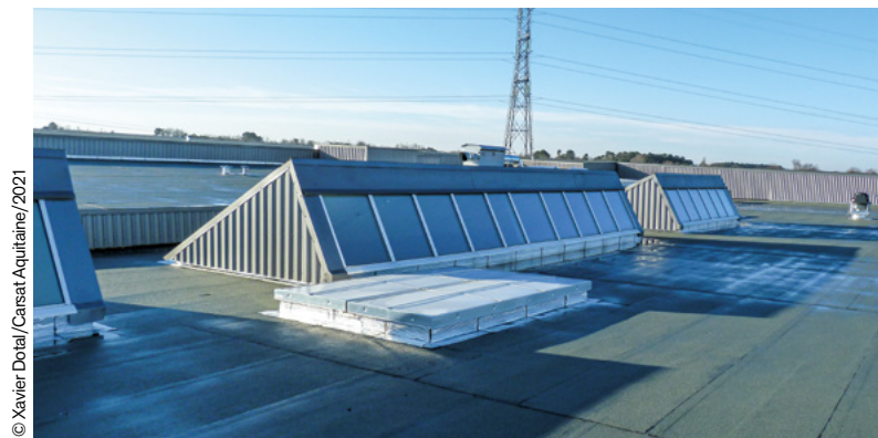
Photo 5.2 – Exemple de sheds orientés au nord.
