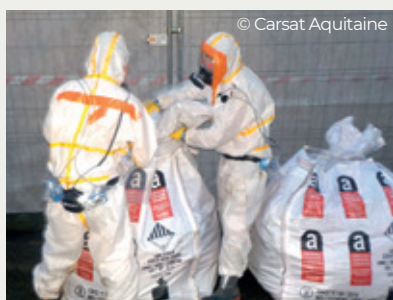
Exemple 1 Fermeture des sacs déchets
