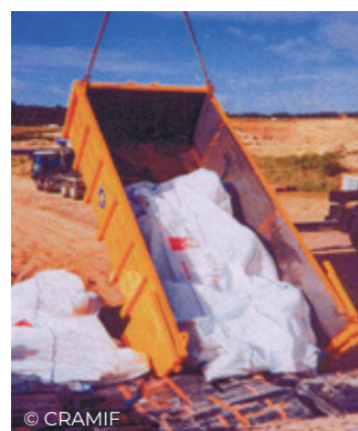
Dépose d'un emballage de la dimension d'une benne dans une alvéole
