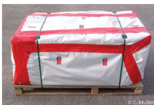
Emballage d'un lot de plaques déposé sur une palette
