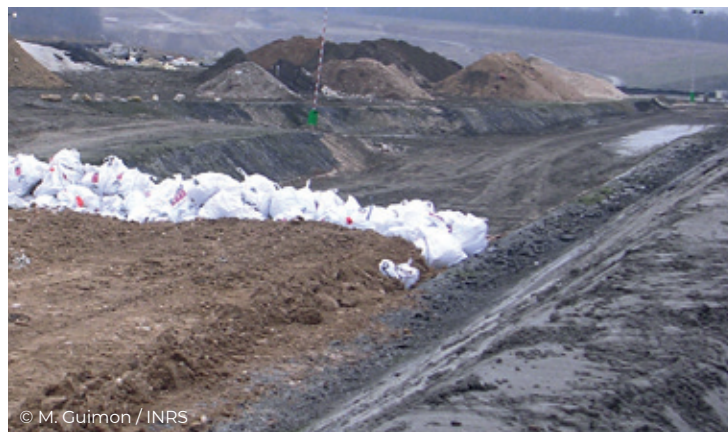
Casier amiante en cours d'exploitation. Recouvrement à l'avancée
