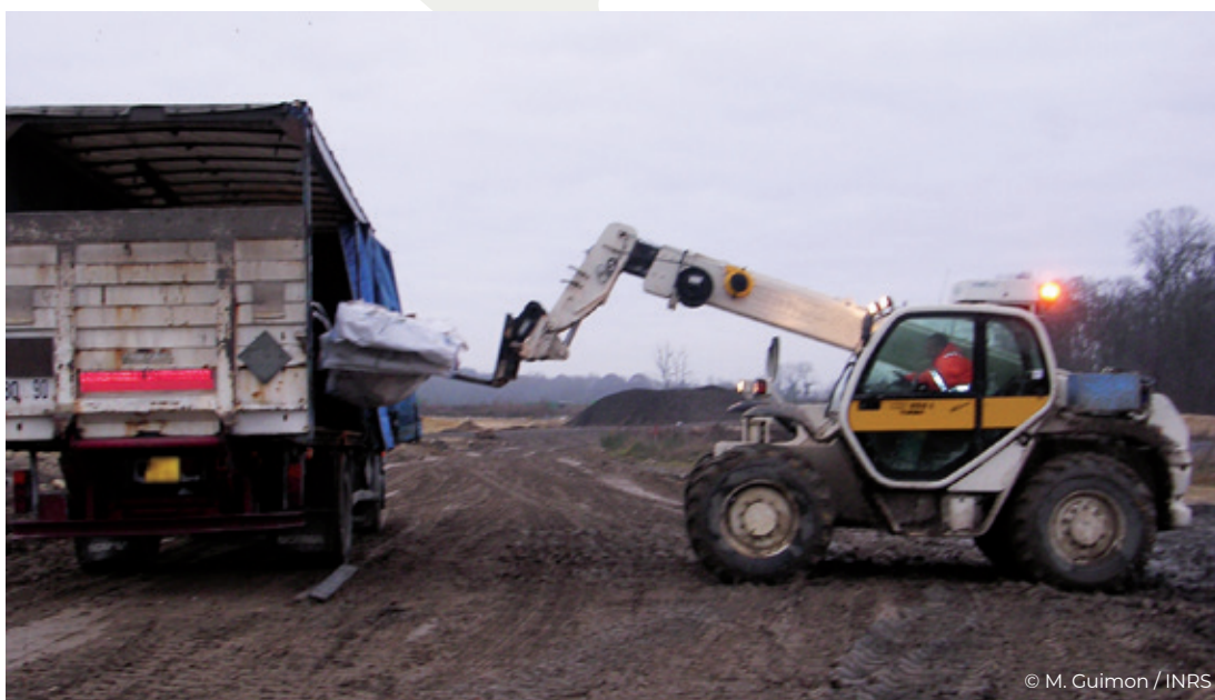
Déchargement de plaques d'amiante-ciment à l'aide d'un engin de manutention à cabine pressurisée
