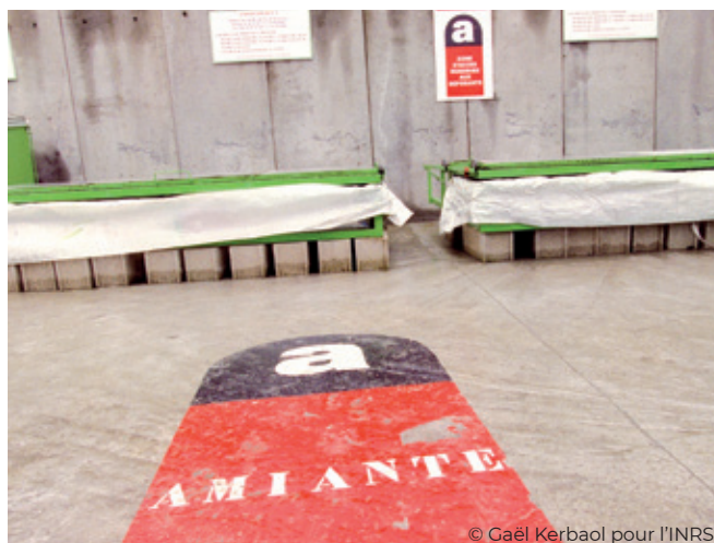
Dépôt bag maintenu dans une structure avec couvercle
