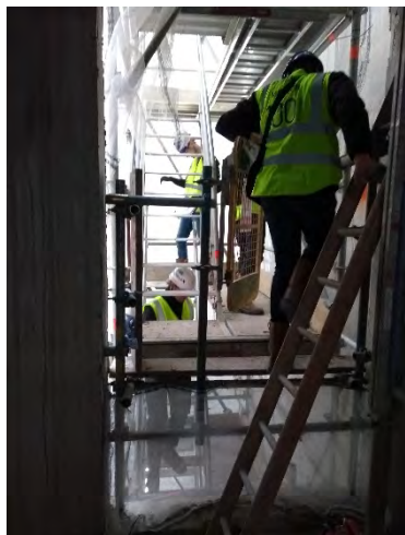
(d) Temporary ladder and stairs.
