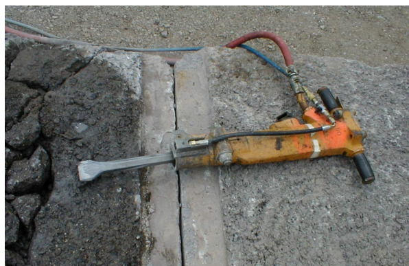
Búa khoan được trang bị hệ thống phun nước để kiểm soát bụi. Vòi phun nước được gắn trên khung búa khoan ở bên phải bộ phận đục. Lưu ý phần bê tông ướt ở bên trái do phun nước.
