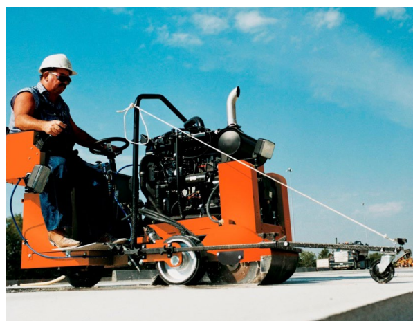
Công nhân cắt rãnh trên đường bê tông bằng xe cửa với hệ thống cấp nước tích hợp.
