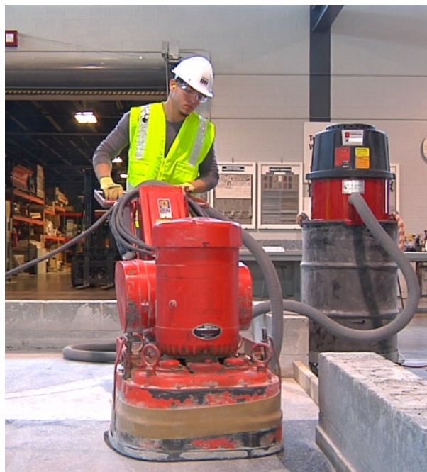
Công nhân cắt vát sàn đá granite trong nhà bằng máy cắt vát và hệ thống hút bụi (ở nền sau).
