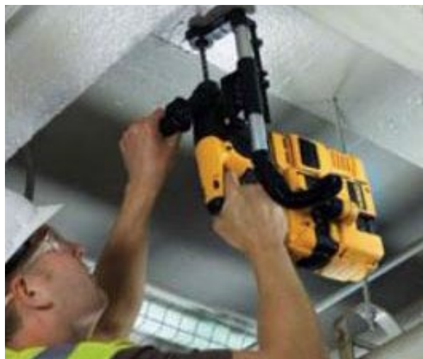
Công nhân khoan bê tông bằng búa quay được trang bị tấm che và hệ thống thu bụi. Lưu ý tấm che quanh mũi khoan, ống màu bạc và màu đen, cùng bộ thu bụi được gắn tinh gọn vào máy khoan.
