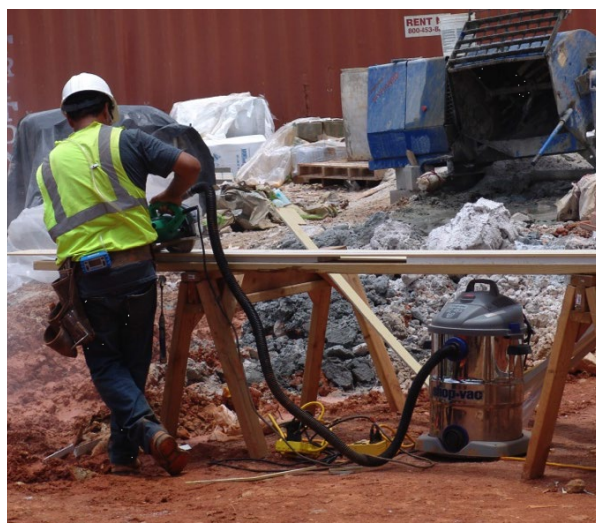
Công nhân cắt tấm xi măng sợi ngoài trời bằng máy cưa điện cầm tay với hệ thống hút bụi. Hệ thống thu bụi bao gồm tấm che trên cưa, ống dẫn và bộ thu bụi được đặt giữa các bộ cưa.
