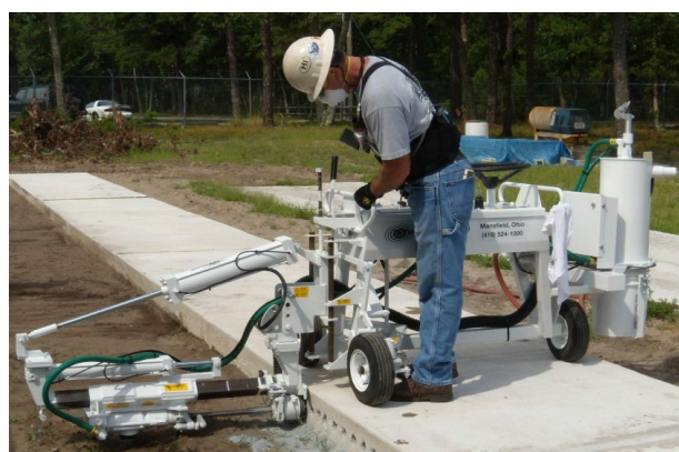
Công nhân khoan lỗ theo hàng ngang trên tấm bê tông bằng máy khoan chốt. Tấm che bao quanh mũi khoan ở nơi mũi khoan đi vào bê tông và vật chứa ở bên phải là bộ thu bụi. Công nhân đeo thiết bị bảo vệ hô hấp.
