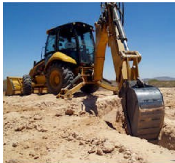
Retroexcavadora con cabina cerrada.
