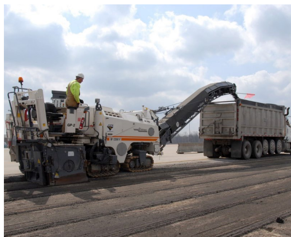
Fresadora de carretera fresando asfalto y cargando los escombros en un camión de transporte.
