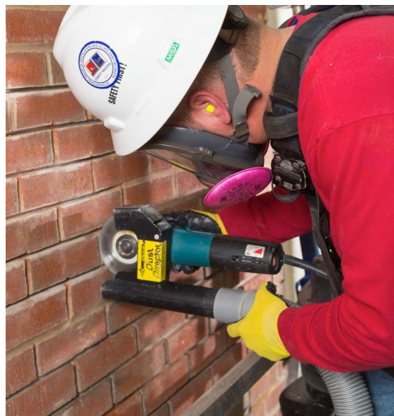
Trabajador amolando mortero entre ladrillos con una amoladora de mano equipada con una cubierta y un sistema de recogida de polvo. Además, el trabajador utiliza protección respiratoria.
