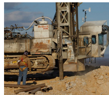
Plataforma de perforación montada en un vehículo utilizando agua en la broca. La cabina cerrada del operador está a la derecha.
