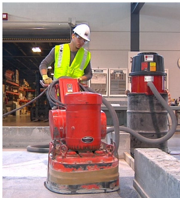
Trabajador fresando suelo de granito en interior con fresadora y sistema de eliminación de polvo (fondo).
