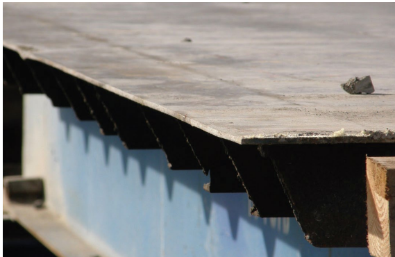
Imagen 2. Los bordes metálicos pueden cortar las líneas de vida y las cuerdas de seguridad.
