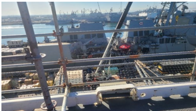
La imagen muestra el uso de una barandilla en el borde de la cubierta para evitar que los trabajadores caigan a un nivel inferior.
