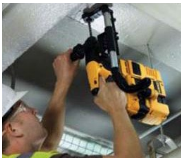
Trabalhador perfurando concreto com martelo rotativo equipado com cobertura e sistema de coleta de poeira. Observe a cobertura ao redor da broca, a mangueira prateada e preta e o coletor de poeira estão convenientemente presos à furadeira.
