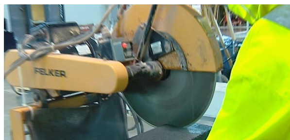
Trabalhador cortando bloco de alvenaria em uma serra de alvenaria estacionária equipada com sistema integrado de fornecimento de água que alimenta continuamente a lâmina com água. Observe a mangueira de abastecimento de água presa ao topo da cobertura ao redor da lâmina.
