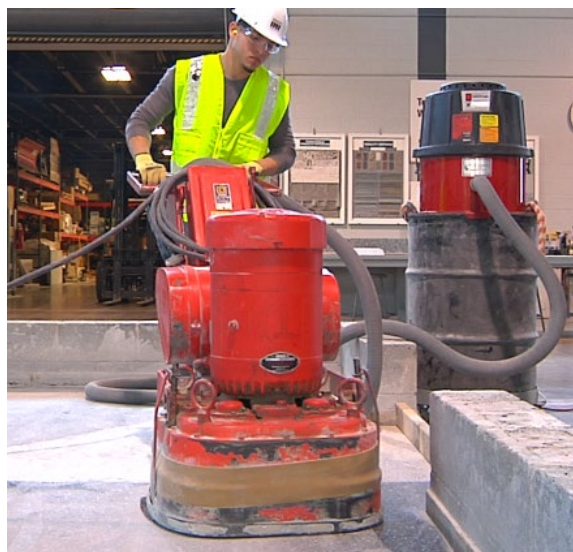
Trabalhador fresando piso de granito em ambientes internos com fresadora e sistema de coleta de pó (fundo).
