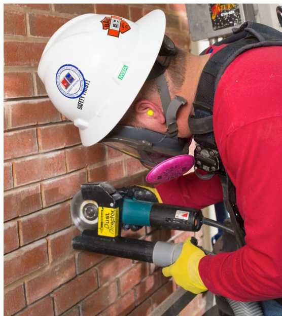
Trabalhador esmerilhando argamassa entre tijolos com uma esmerilhadeira portátil equipada com uma cobertura e sistema de coleta de poeira. Além disso, o trabalhador está usando proteção respiratória.
