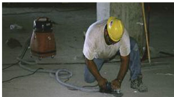
Trabalhador esmerilhando piso de concreto com esmerilhadeira acoplado ao coletor de pó (fundo).
