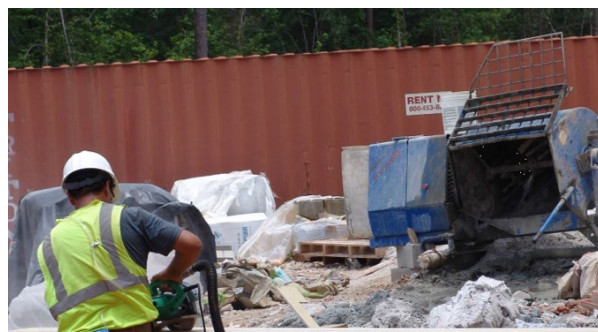
Trabalhador cortando placa de fibrocimento ao ar livre usando uma serra elétrica portátil e sistema de coleta de poeira. O sistema de coleta de poeira consiste na cobertura na serra, mangueira e coletor de poeira posicionados entre os cavalos de serra.
