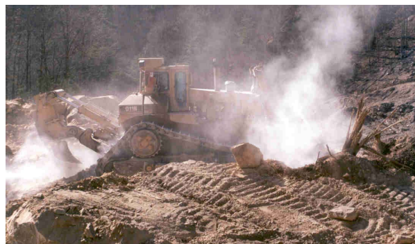
Terraplenagem utilizando trator equipado com cabine do operador fechada. Foto cedida pelo NIOSH.
