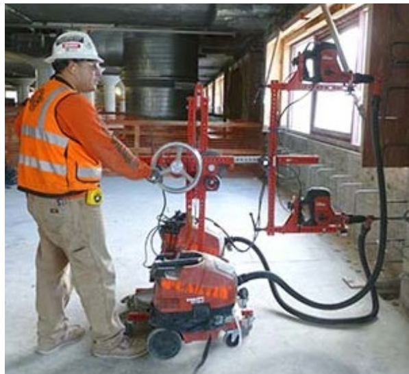
O trabalhador está fazendo furos horizontais em uma parede de concreto usando duas furadeiras montadas em suporte, cada uma equipada com um coletor de poeira. Observe que as coberturas ao redor de furadeiras, mangueira preta e coletor de poeira estão presas ao suporte.
