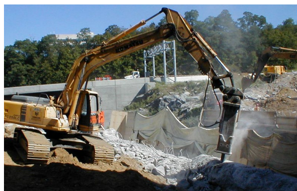
Escavadeira equipada com cabine fechada e enxada demolindo uma parede de concreto.
