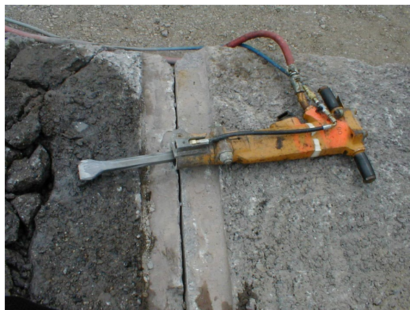
Britadeira equipada com sistema de entrega de spray de água para controlar a poeira. O bico de água é montado na estrutura da britadeira à direita do cinzel. Observe o concreto molhado à esquerda do spray de água.
