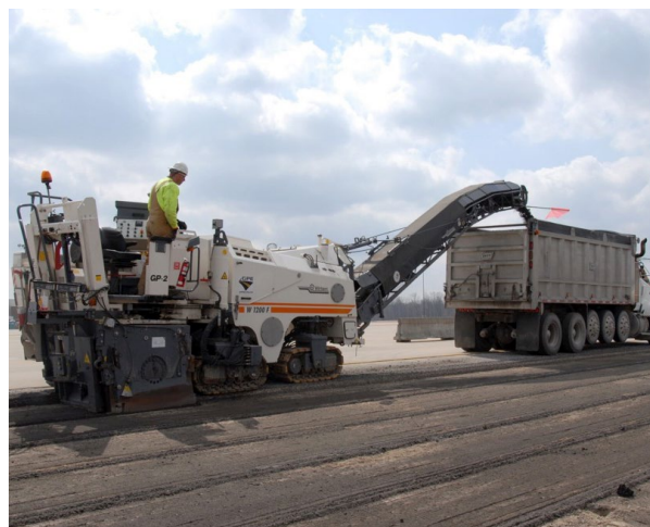
Fresadora fresadora de asfalto rodoviário e carregamento de detritos em caminhão de transporte.
