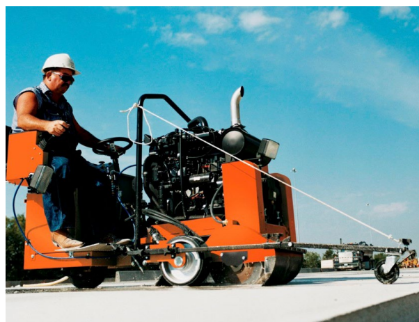
Trabalhador cortando um sulco em estrada de concreto com serra dirigível usando sistema integrado de fornecimento de água.
