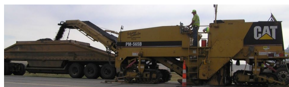
Fresadora, fresadora de asfalto rodoviário e carregamento de detritos em caminhão de transporte.
