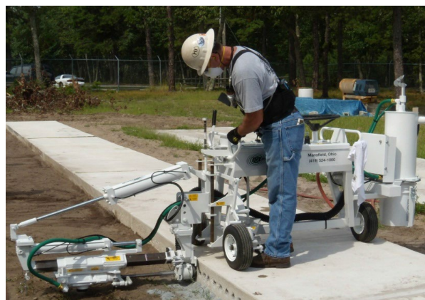
Trabalhador fazendo furos horizontais em laje de concreto com uma sonda de perfuração.
