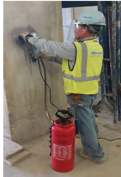
Ejemplo de esmeriladora manual con sistema integrado de suministro de agua.
