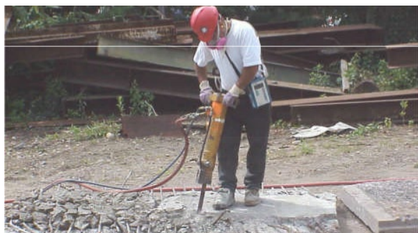
Un empleado astilla hormigón con un martillo neumático utilizando para ello un accesorio de aspersión de agua para controlar el polvo.
