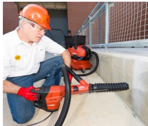
Empleado taladrando en concreto con un martillo perforador equipado con una cubierta y un sistema de eliminación de polvo
