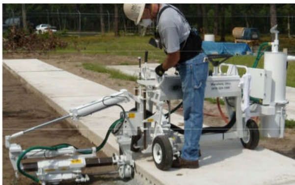
El trabajador perfora agujeros horizontales en una losa de concreto con un taladro. El revestimiento rodea el acero de perforación donde entra en el concreto y hay un recipiente a la derecha que absorbe el polvo. El operador usa protección respiratoria.
