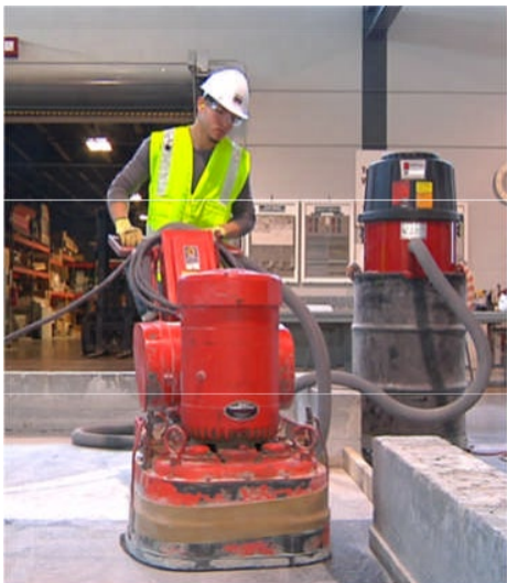
Trabajador fresando suelo de granito en interior con una fresadora y un sistema de aspiración de polvo (fondo). foto cortesía de la OSHA
