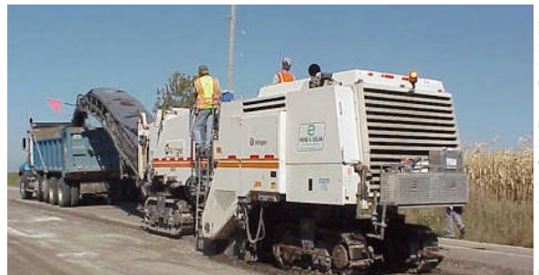
Fresadora cortando asfalto y cargando los escombros en un camión.
