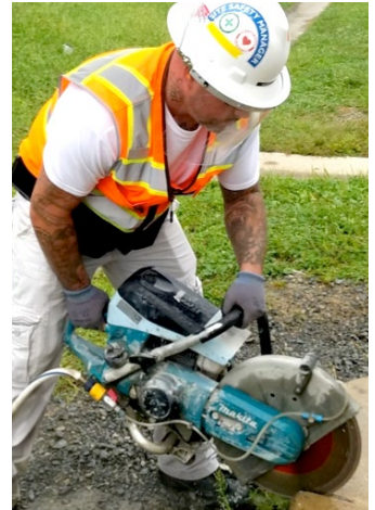
Aplicar agua a la hoja de una sierra mecánica manual reduce la cantidad de polvo que se crea al cortar.
